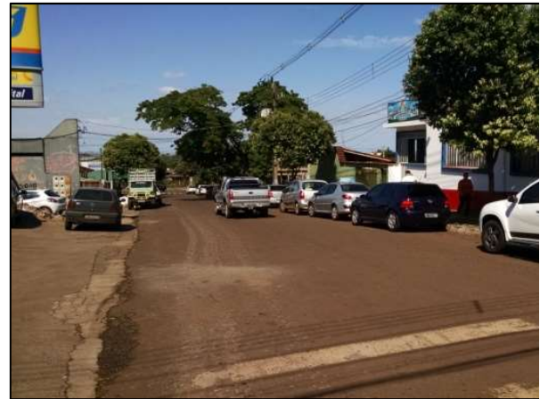
Figura 14 – Via com pavimentação asfáltica em Marialva/PR.
