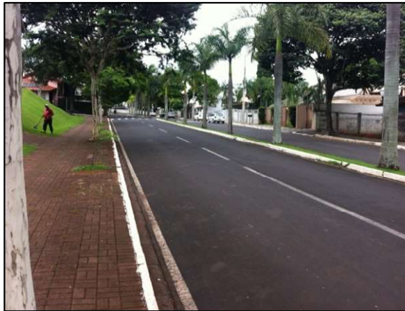
Figura 13 – Via com pavimentação asfáltica em Marialva/PR.
